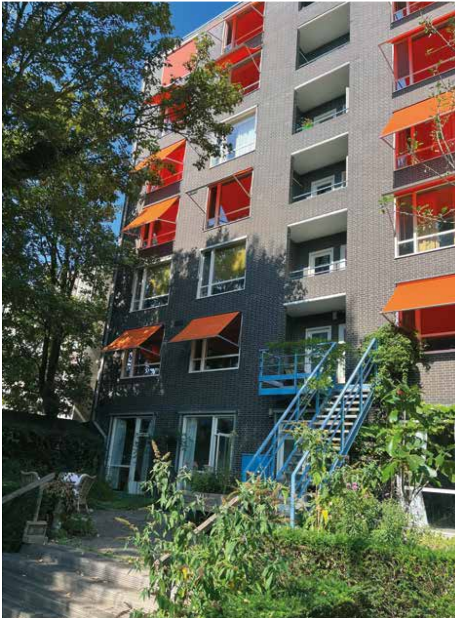
Het gebouw van Stichting Eendracht-Anslo vanuit de tuin.
