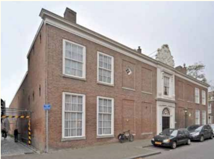
Hooftshofje (1756). Het voorgebouw achter de monumentale straatgevel gaat hoger op dan de hofjeswoningen, zoals links te zien. De rijk behandelde middenpartij met kuifstuk boven de dakvoet, is als risaliet (voornuitspringende partij van een bouwlichaam) uitgevoerd met de toegangspoort naar de woningen. (foto ©ejn)
